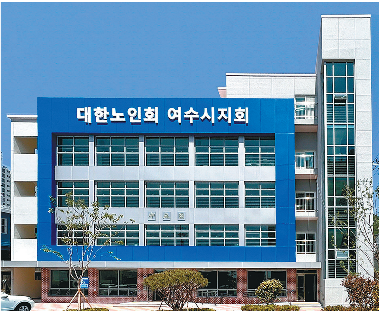
부영그룹이 최근 전남 여수시에 신축해 기증한 노인회관 ‘우정원’ 전경.
